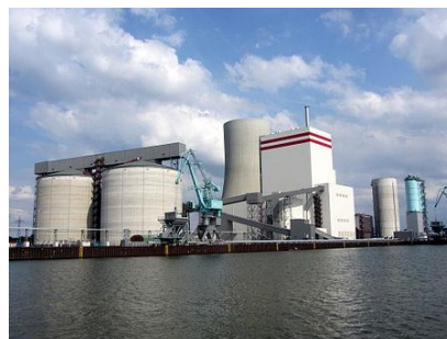
Trianel-Kraftwerk in Lünen Nordrhein-Westfalen
